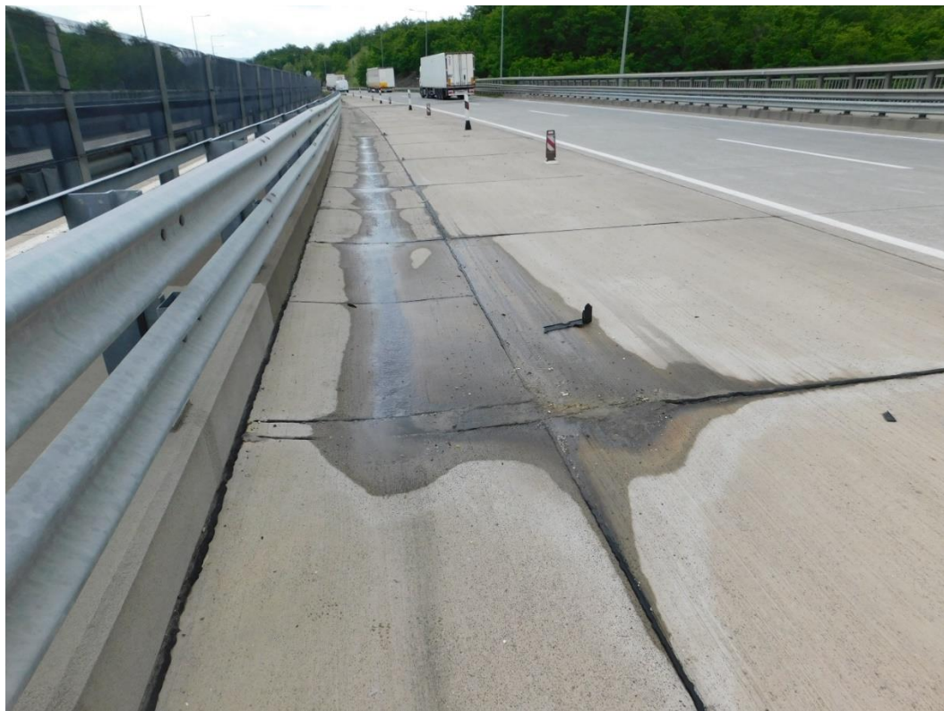
3. ábra: Beton burkolatú pályaszerkezetből kilépő víz esésirányába nézve (szerző felvétele).
