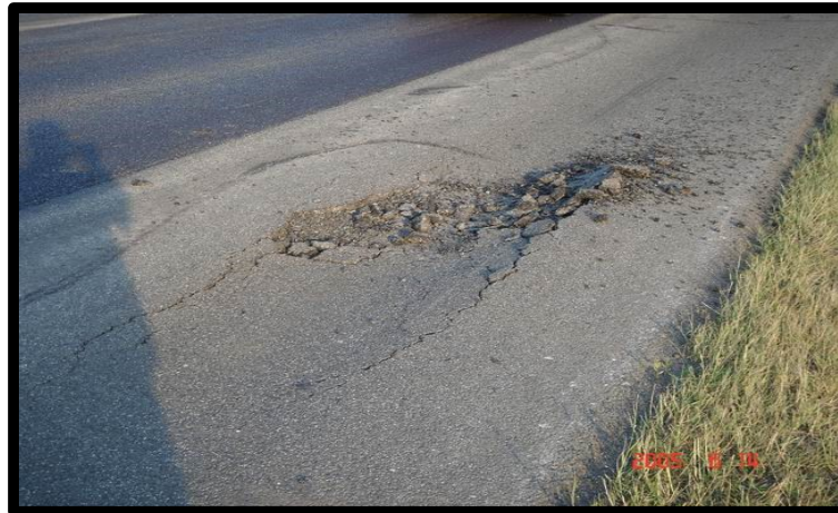
17. ábra: Pályaszerkezet tönkremenetel.
