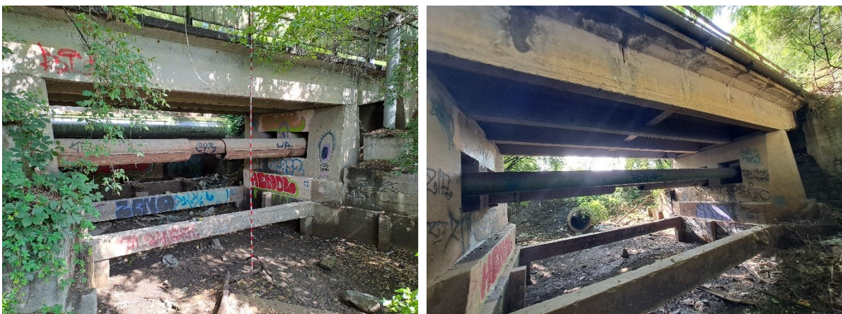
5-6. ábra: A híd oldalnézete az öböl felől és a zsilip felől – háttérben az öbölhöz tovább vezető egyetlen betoncsővel (szerző felvétele).
