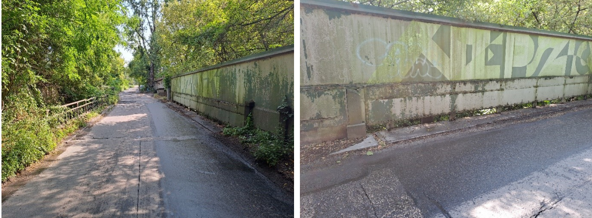
3-4. ábra: A híd kocsipálya nézete északi irányba és az öböl felőli hídkorlát, a ráépített tömör kerítéssel (szerző felvétele).
