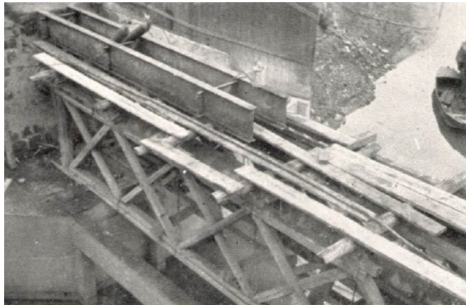
14. ábra: A régi vasgerendás híd bontása az 1930-ban aláépített fa provizóriummal [8].
