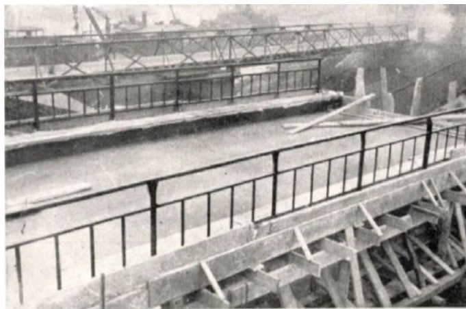
18. ábra: Az 1932-ben épített közel kész felszerkezet, útcsatlakozás nélkül, háttérben a gyalogos híddal [8].
