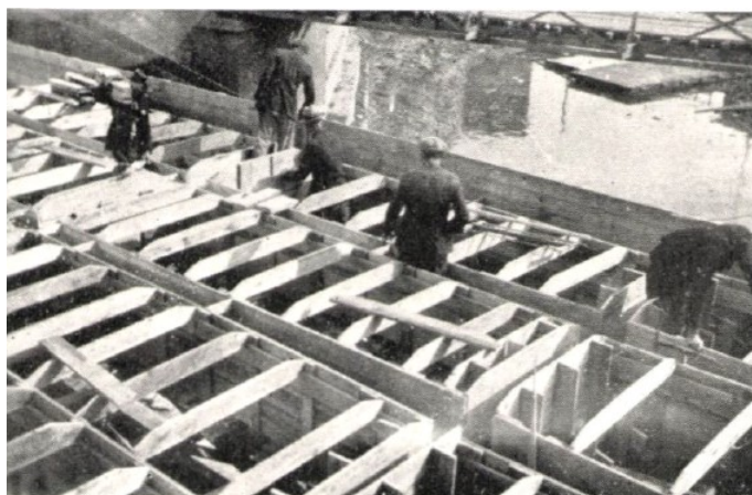
16. ábra: Az 1932-ben épített felszerkezet zsaluzata [8].
