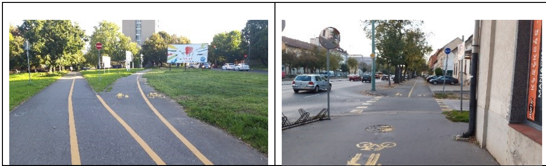
Miskolc, Szentpéteri kapu (26. sz. főút) – Huba utca, kerékpárút a járdán, értelmezhetetlen megoldás
