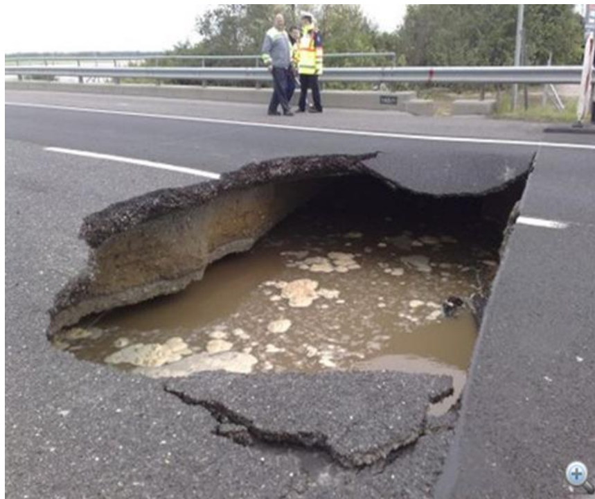
2. ábra: Beszakadt burkolt padka [forrás: internet]
