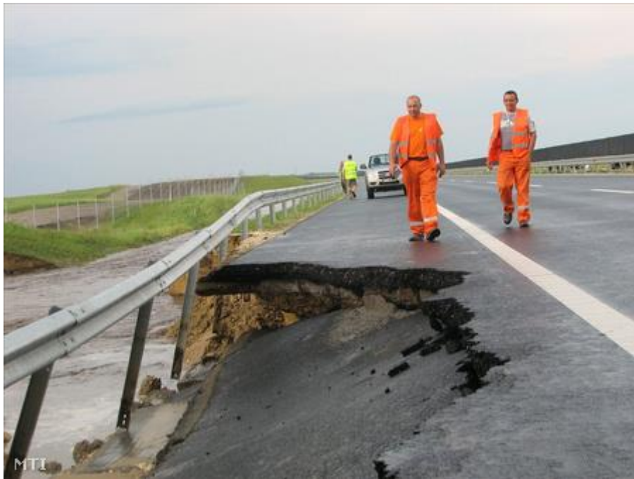
1. ábra: Autópálya burkolatának beszakadása özönvízszerű esőzés hatására [forrás: internet]
