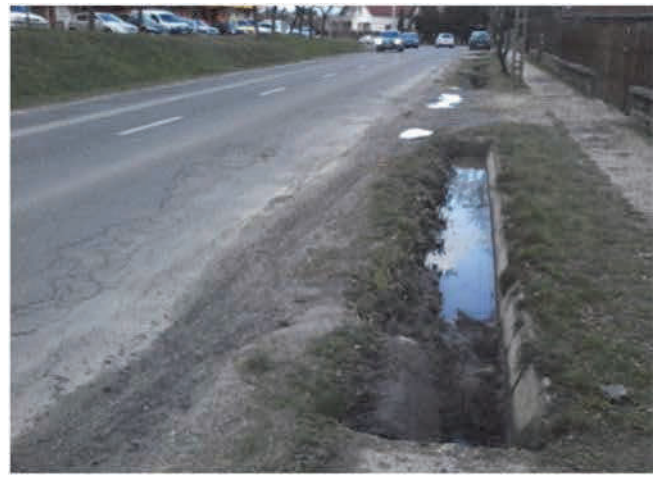
7. Ábra. Pangó víz a csapadékvíz-elvezető rendszerben
