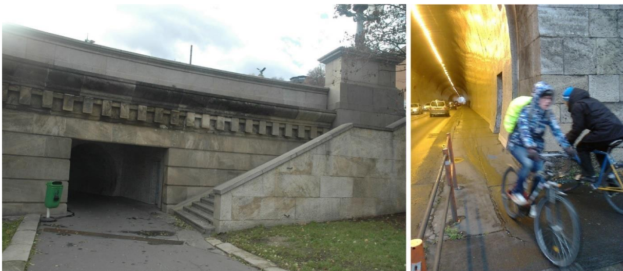
8. ábra: Budai hídfő alagútja, Várhegyi Alagút Attila út felőli bejárata
