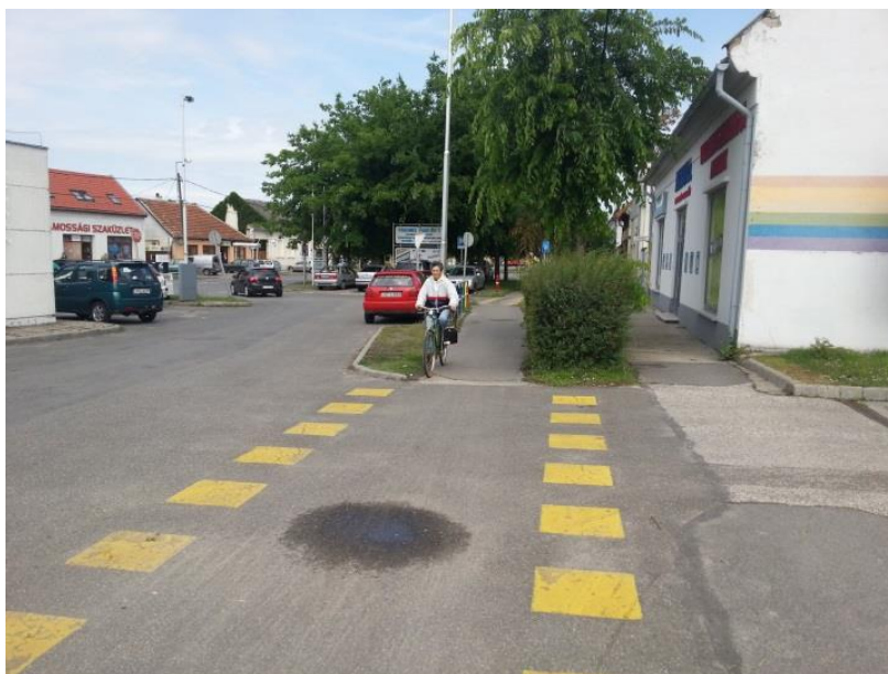
11. ábra: Egyoldali kétirányú kerékpárút átvezetése Baján
