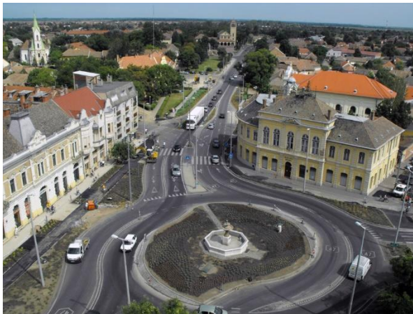
30. ábra: Hódmezővásárhelyen, a Kálvin téren épült 3 ágú turbó körforgalom előtte (a) – utána (b) hátrahúzott, „eltolt” kijelölt gyalogos-átkelőhelyekkel (Fotó: Rigó Mihály)
